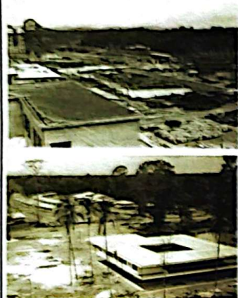
เริ่มก่อสร้าง โรงงานทุ่งสง
