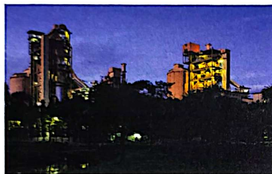
ติดตั้งเครื่องจักร ทุ่งสง 4
