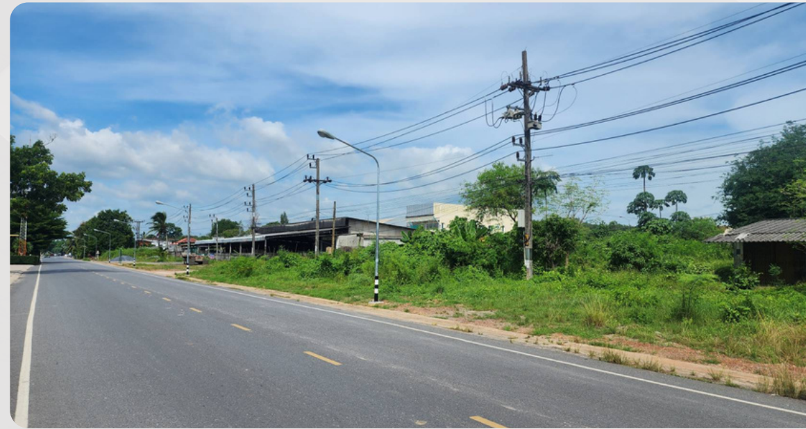
2. โครงการติดตั้งเสาไฟฟ้าสองสว่างถนนสาย 403 (สายเก่า) หมู่ที่ 1
