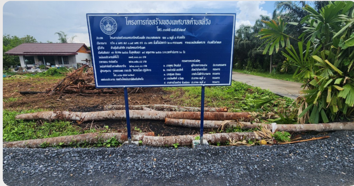
4. โครงการก่อสร้างถนนคอนกรีตเสริมเหล็ก สายนายสมหมาย ซอย 1 หมู่ที่ 4
