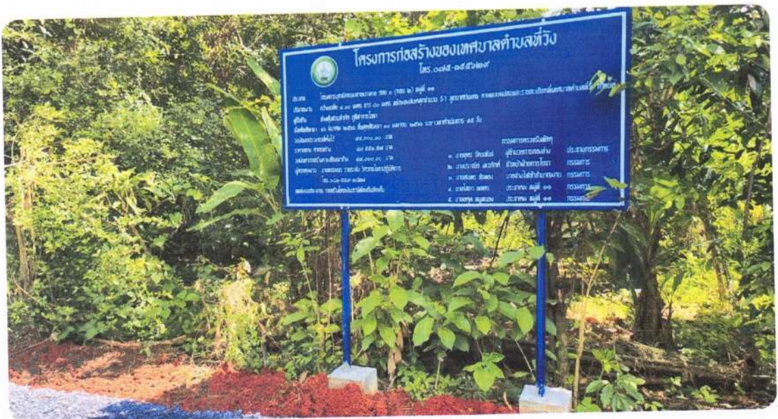
34.โครงการบุกเบิกถนนสายกาลาย ซอย 3 (ตอน 2) หมู่ที่ 11
