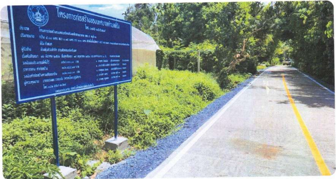
36.โครงการก่อสร้างถนนคอนกรีตสายเก่าสาย ซอย 5 หมู่ที่ 11
