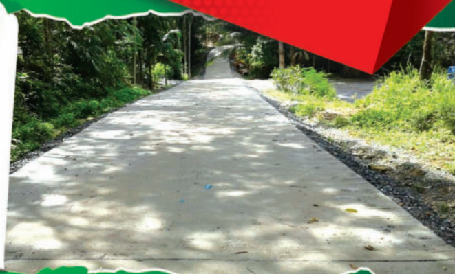
ก่อสร้างถนนคอนกรีตเสริมเหล็กสายทองเนื้อเก้า หมู่ที่ 9
