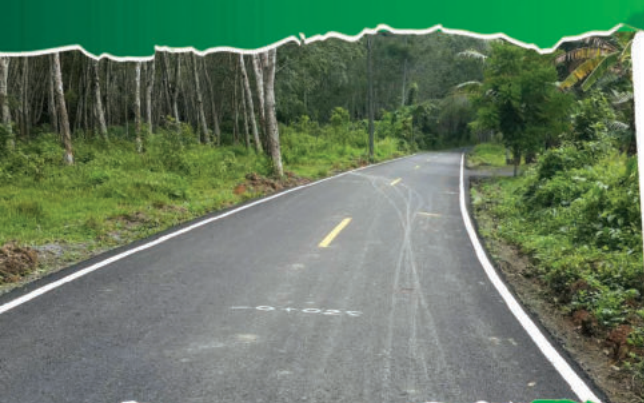
ก่อสร้างถนนแอสฟัลต์ติกคอนกรีตสายควนพล-ควนกอ หมู่ที่ 2
