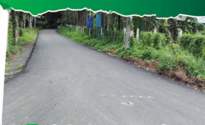
ก่อสร้างถนนแอสฟัลต์ติกคอนกรีตสายหนองจืด หมู่ที่ 2
