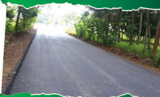
ปรับปรุงถนนลาดยางสายหมอกลำ-โคกกฐิน หมู่ที่ 7
