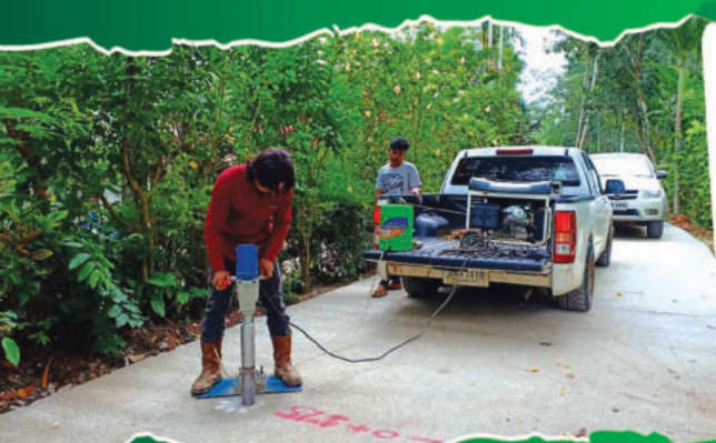
ก่อสร้างถนนคอนกรีตเสริมเหล็กสายครุเปอร์ หมู่ที่ 6
